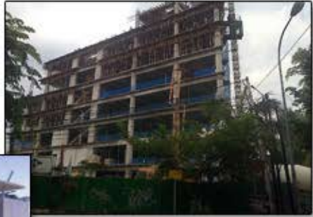
Kwitang Office Park, Jakarta
